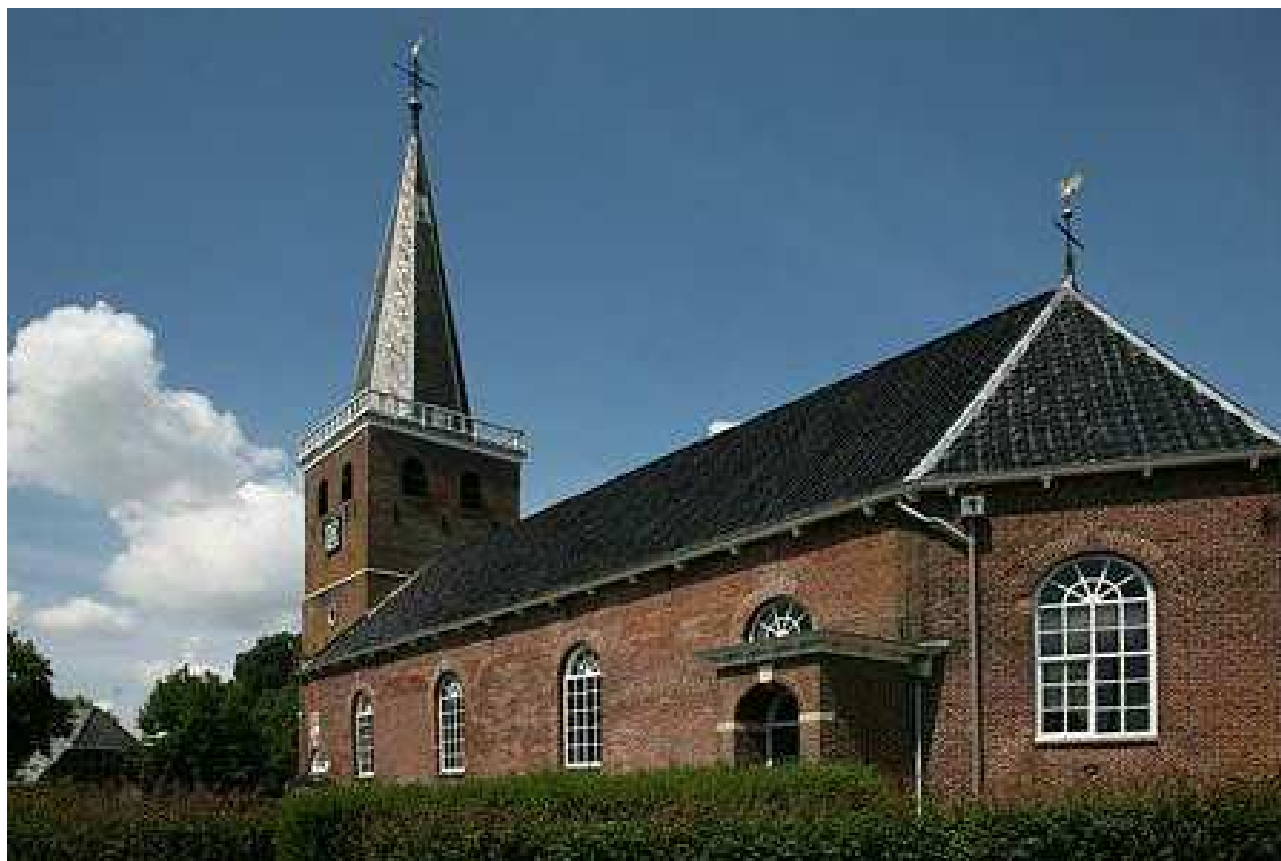
Johanneskerk Tsjerkebuorren 9 8625 HA OPPENHUIZEN
