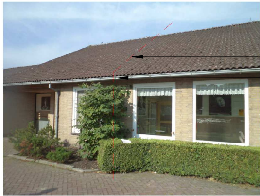
Sloopleijn Kopschotje plaatsen zinkengoot
